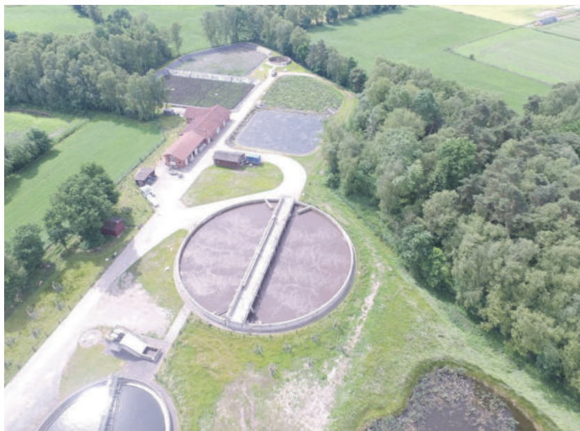
Kläranlage Lauenbrück. Foto: Archiv
