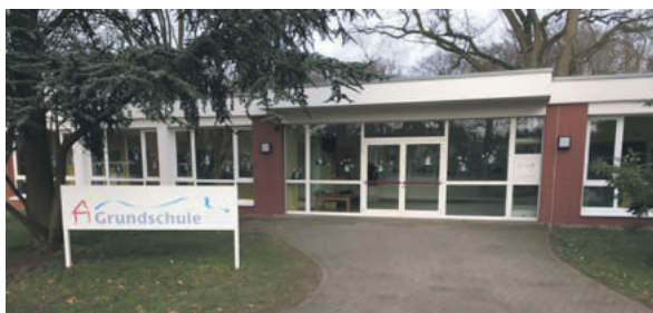
Grundschule Lauenbrück. Foto: www.sgfintel.de
