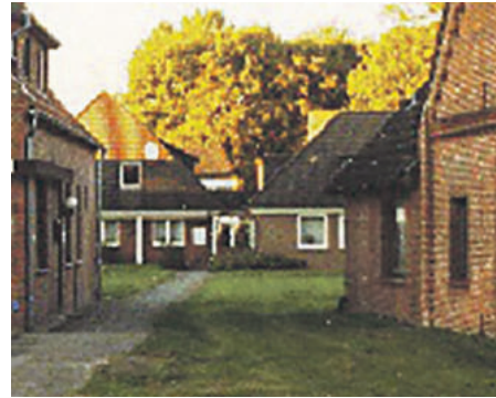
Veränderter Zugang des Rathauses 1982 von der Berliner Straße aus.
